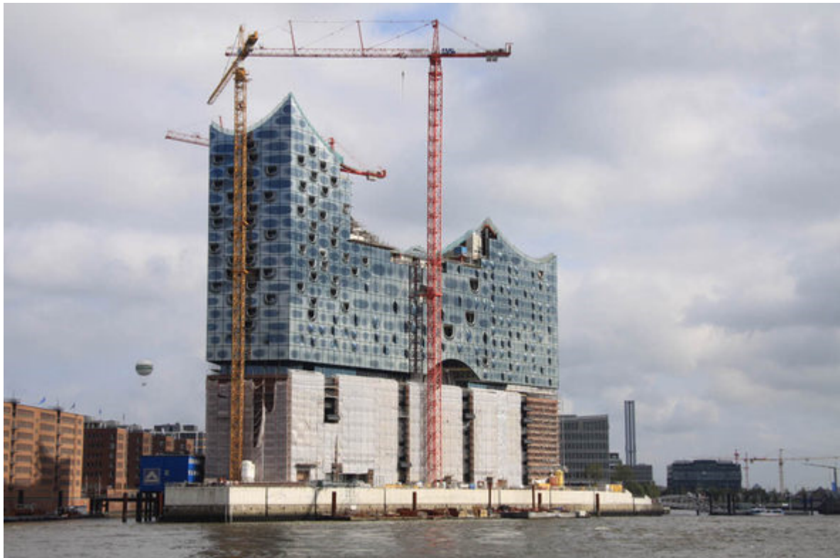
Hamburgs Prestigeobjekt: die Baustelle der Elbphilharmonie Foto: dick
